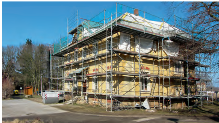
Sanierung des in der Gründungszeit 1899 gebauten „Rektorats“.
